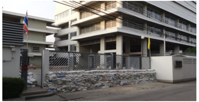
学校前、洪水対策用土のう
